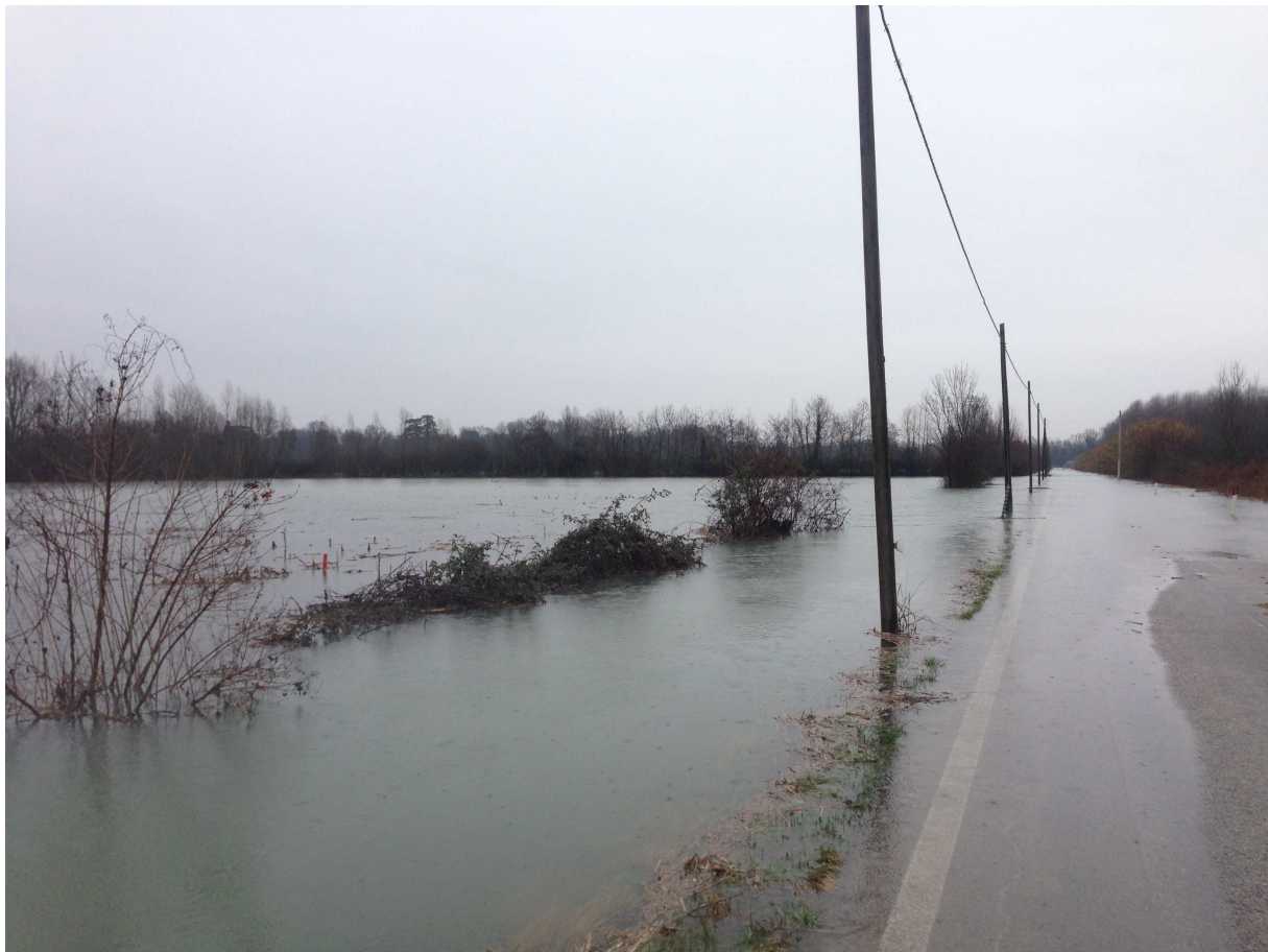
Figura 24 - Allagamenti presso Ariis - Rivignano
